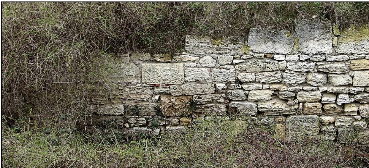
Рис. 5. 26 куртина III строительного периода (VI-VII вв.). Квадровая кладка внутренней облицовки. Современное состояние. Снято с севера. Фото автора
