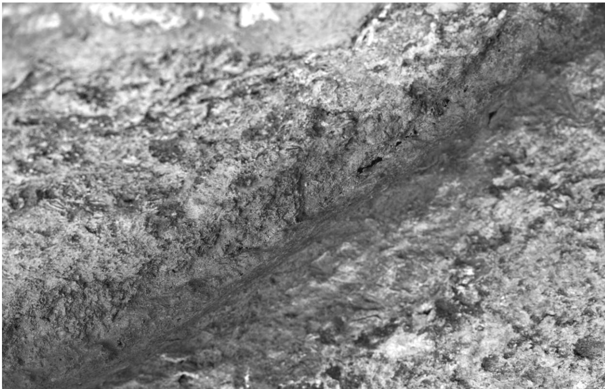
Рис. 15. Водоносная трещина над северной «лежанкой» «пещерного храма у городских ворот»
