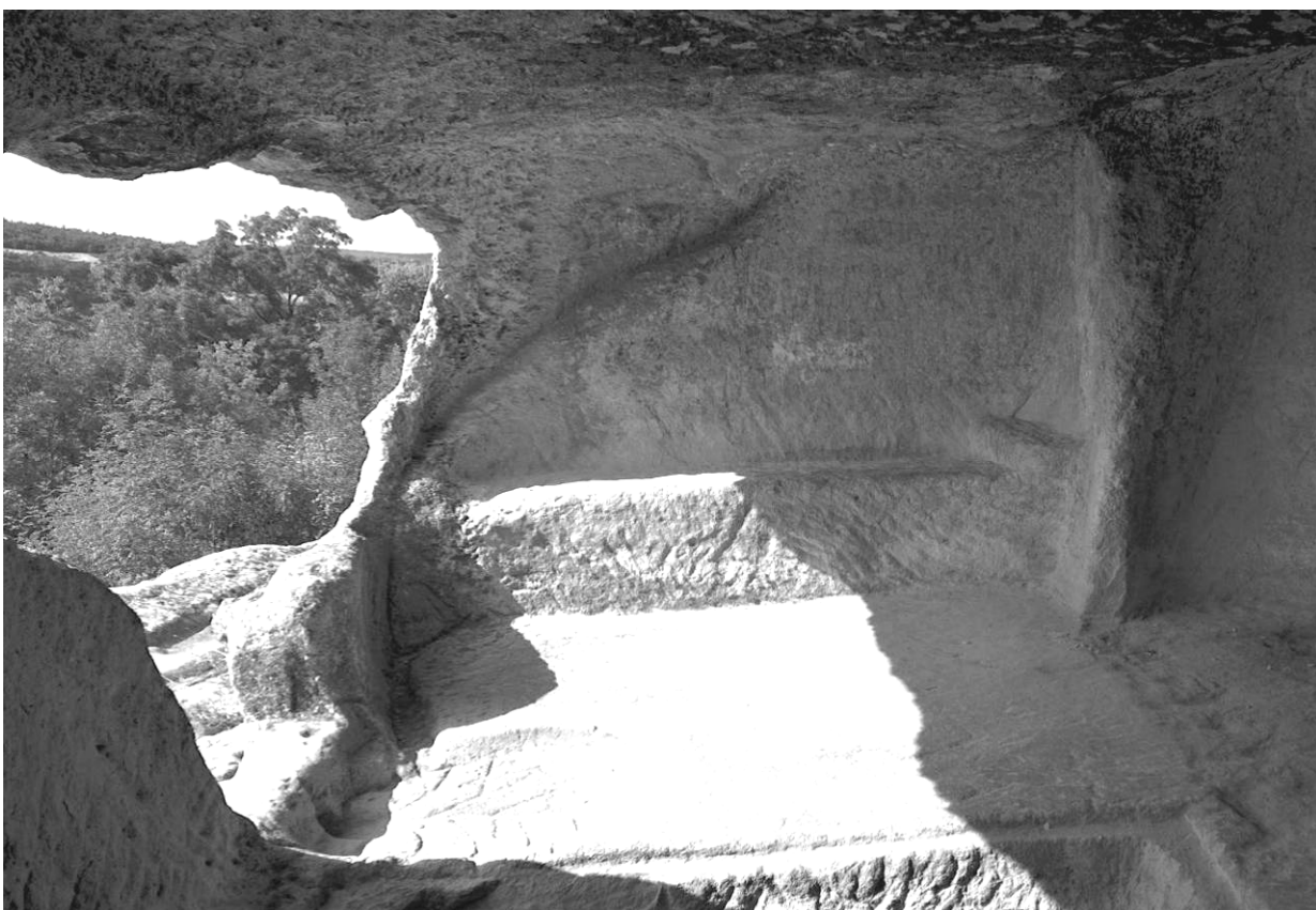
Рис. 14. Водоотводный желобок на северной стене «пещерного храма у городских ворот»
