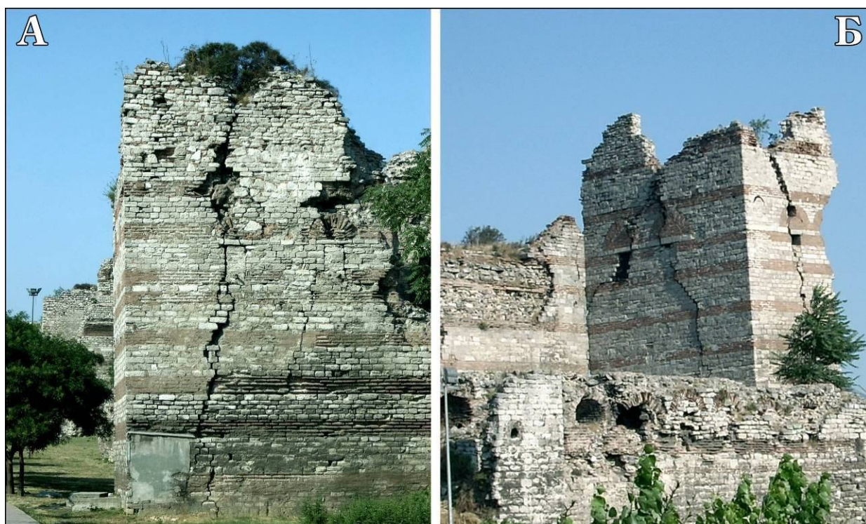
Рис. 19. Башни южного фланга «Стены Феодосия» (Стамбул) со следами сильного сейсмического воздействия. Снято с запада (фото автора)
