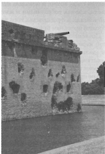
Это не Севастополь, это форт Пуласки в США после бомбардирования в апреле 1862 г. Примерно так должны были выглядеть Константиновская и Александровская батареи в Севастополе после бомбардирования 5(17) октября 1854 г. Современное фото.
