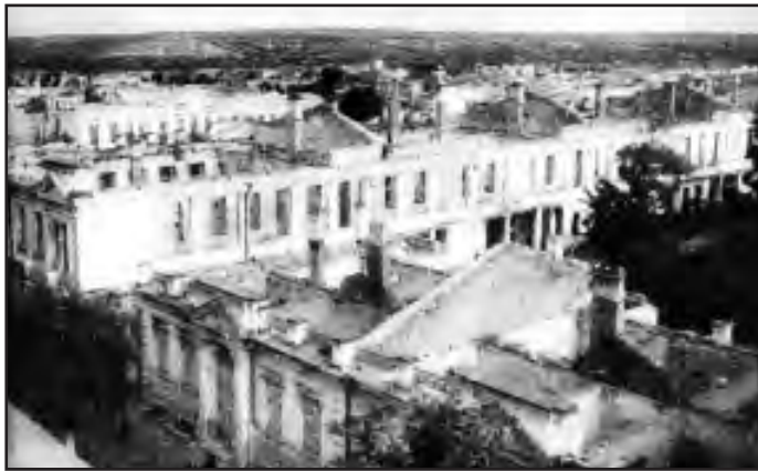
Вид разрушенного во время войны Кишинева.
