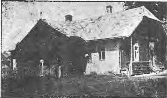
ПРИХОДСТВО В ЗАГІРІУ.
