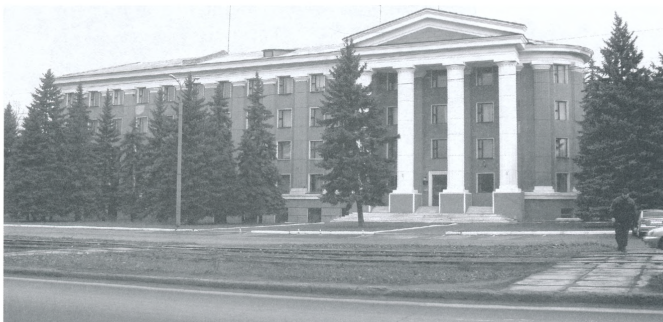
Будівля в/о «Артемвугілля». Центрально-міський район, проспект Леніна, 13
