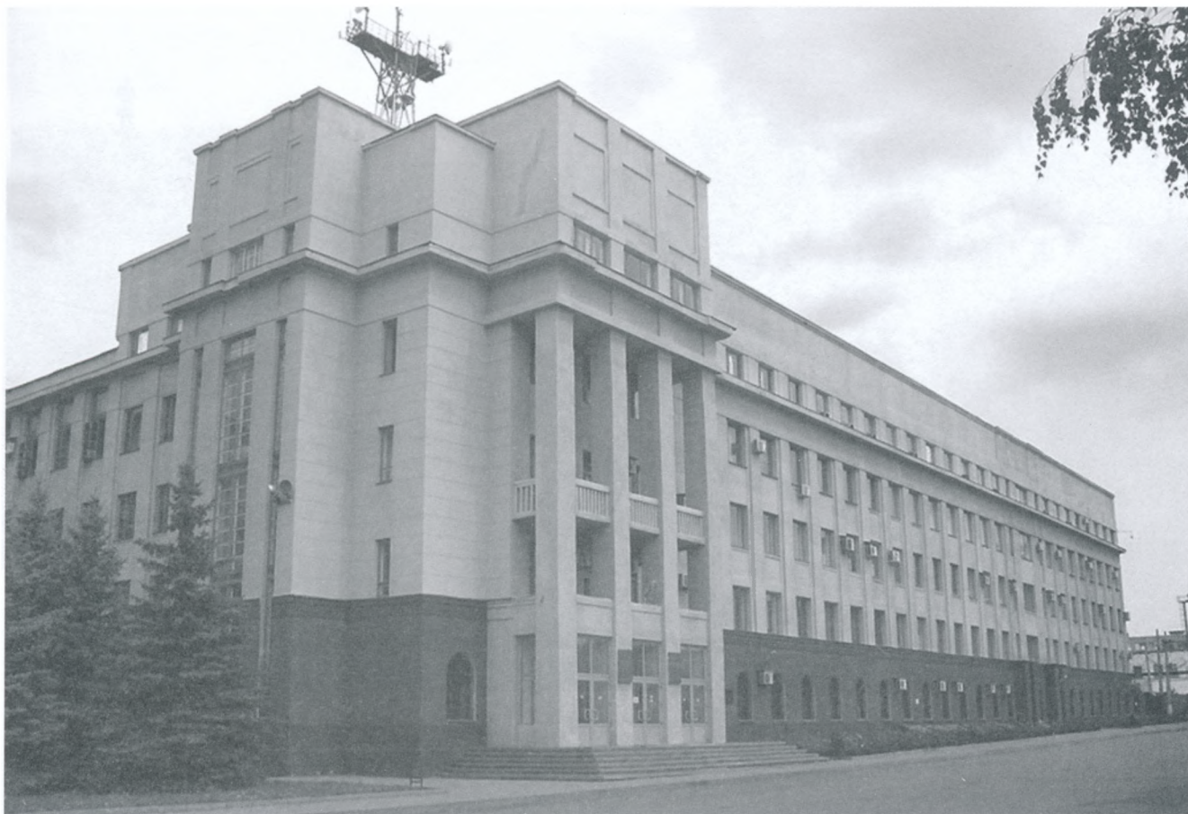
Будівля в/о «Донбасенерго». Центрально-міський район, проспект Леніна, 11
