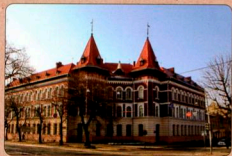
Будинок колишньої школи ім. Ш. Конарського (тепер СШ № 55, вул. С. Бандери, 91) восени 1918 р. використовували як казарми солдати угорського штурмового батальйону. Сучасне фото.
