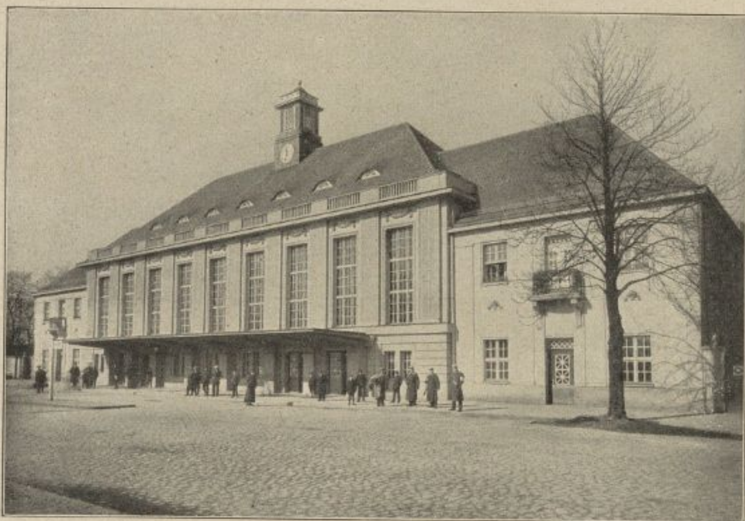
Бромберг. Залізничний двірець. Зверхній вигляд. Зразок модерного залізничного двірця середнього міста.
