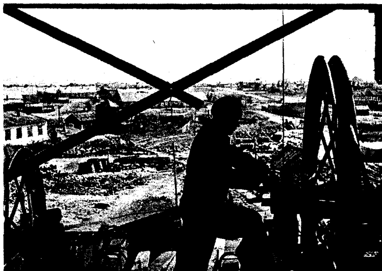
Рис. 3. Монтаж копра відбудованої шахти "Сталінський забій" тресту "Краснолучувілля". 1946 р.
