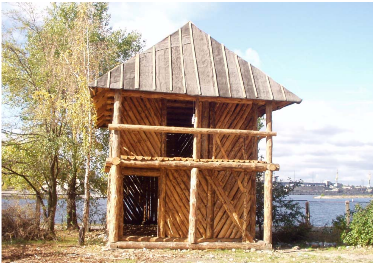
Полномасштабная реконструкция двухэтажного трипольского дома в процессе строительства. Триполье, осень 2003 года.
