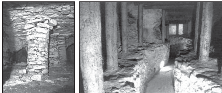
Сучасне кріплення виробок і камер
