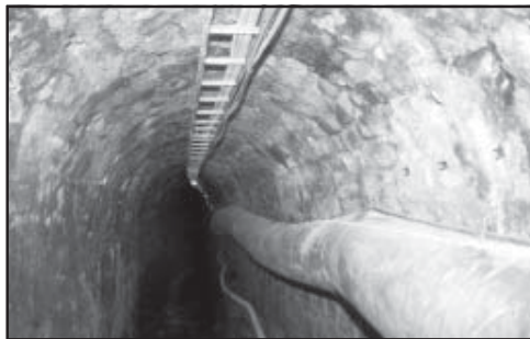
Ділянка з мурованим кріпленням (споруджена у 1806 р.)
