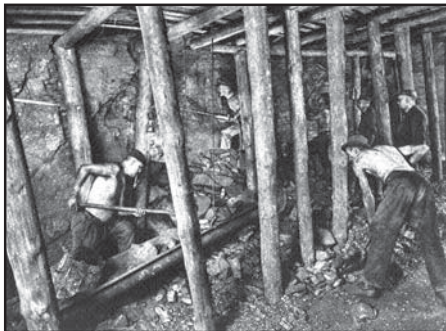
Роботи при стовповій системі розробки з підвішеними жолобами (Катовіце, початок ХХ ст.)
