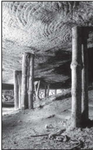
Кріплення камер за допомогою стояків
