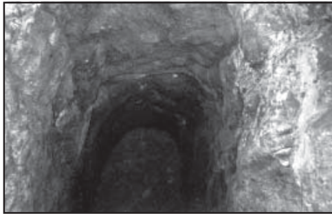
Ділянка штольні без кріплення (споруджена в 1791 р.)
