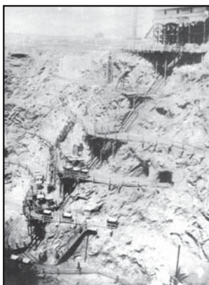
Похилий підйомник, що обслуговував кілька горизонтів на Веселівському руднику («Жовта Річка»), 1911 р.
