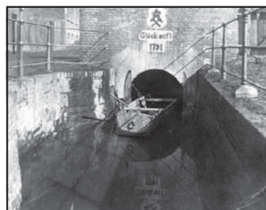
Транспортування вугілля в човнах (водна штольня у м. Забже)
