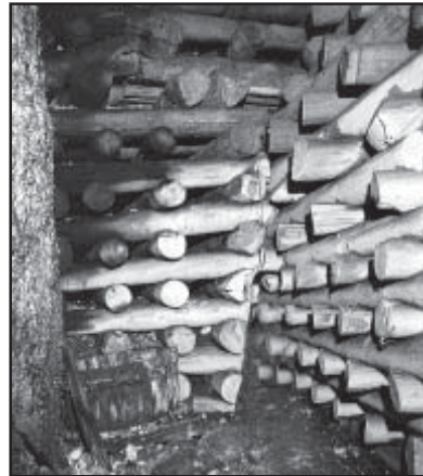
Спорудження дерев'яного костра (за Я. Борляхом, 1719 р.). Сучасний вигляд кострів (клітей)
