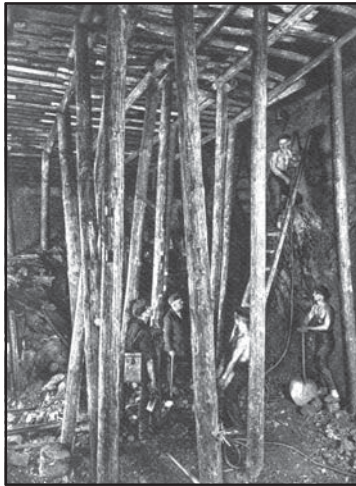
Стадія відбійки вугілля на пласті великої потужності при стовпній системі розробки (Катовіце, початок XX ст.)
