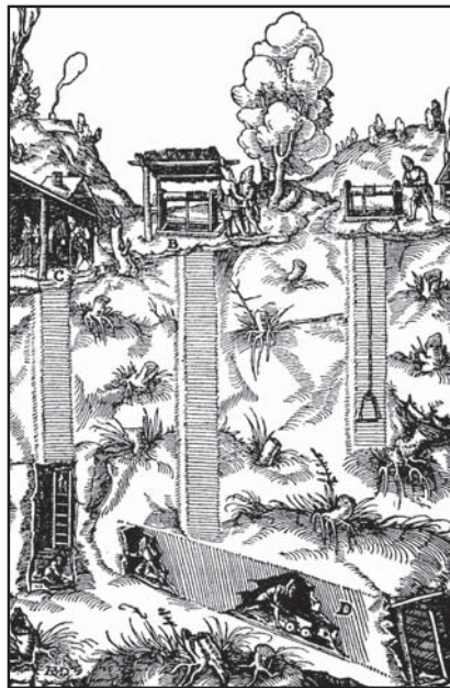
Розкриття покладу за допомогою стволів і штолень (за Г. А'ріколою, 1556 р.)
