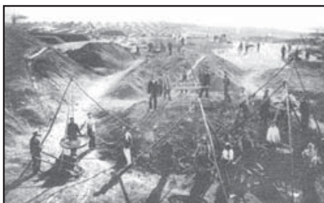
Суше збагачення марганцевої руди на Покровських копальнях
