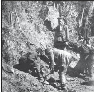
Зарядка шпурів для підривання скельних гірських порід, рудник «Шмаковський», 1903 р.
