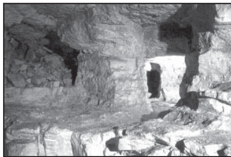
Цілики з вапняку для підтримання виробок
