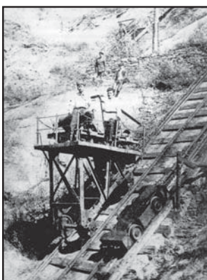
Одноклітьовий підйомник на дві вагонетки з противагою, рудник Пастухова, 1904 р.
