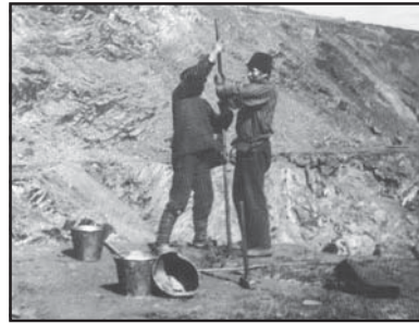
Ручне буріння довгими бурами (так зване ширкове буріння), 1888 р.
