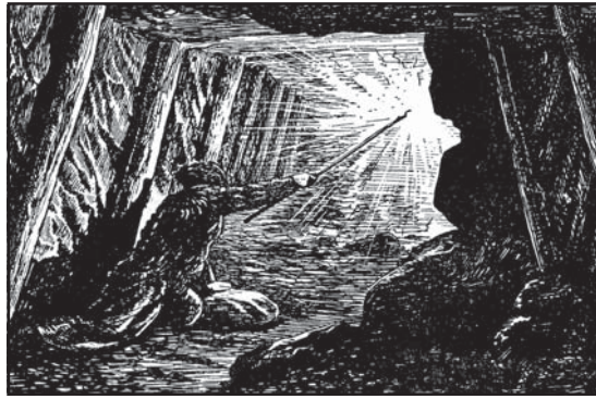
Випалювання газу біля покрівлі виробки
