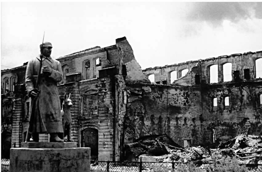
Памятник возле разрушенного здания в Полтаве. Фото 1945 г.
