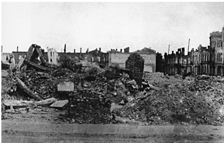
Руины на перекрестке улиц Ленина и Гоголя. Фото 1945 г.
