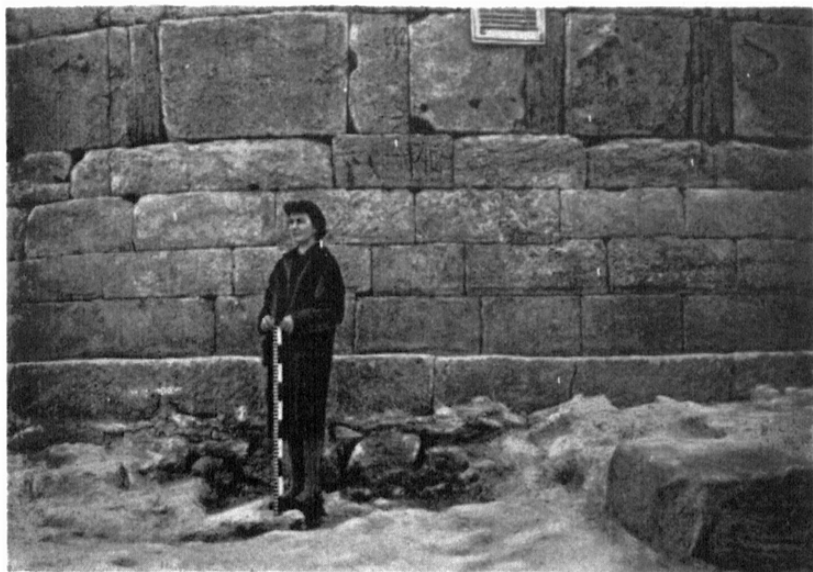
Рис. 10. Облицовка третьего строительного периода башни: цоколь и четыре нижних ряда кладки.
