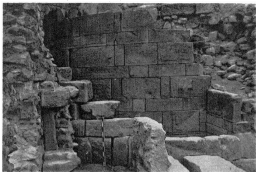
Рис. 4. Первый строительный период (ядро). Метр прислонен к облицовке второго периода. Впритык к этой облицовке (на переднем плане) пристроена 20-я куртина.
