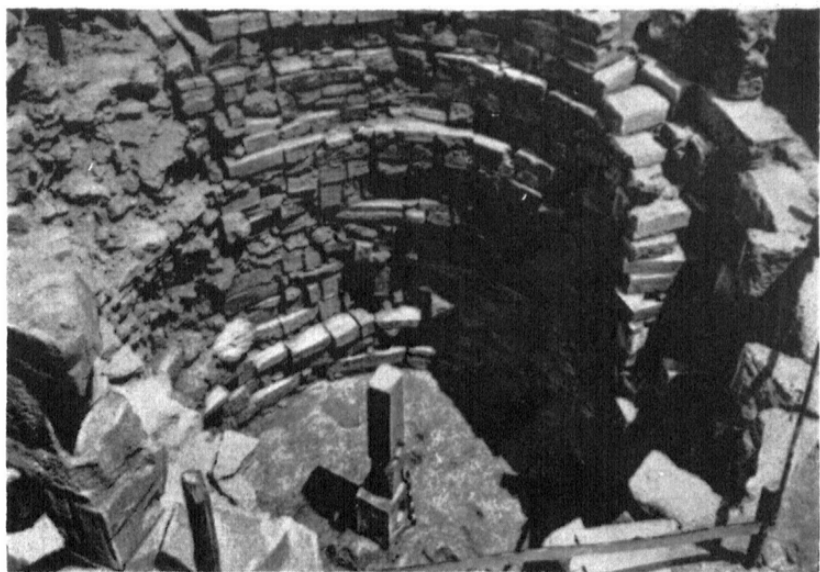
Рис. 5. Внутренняя кладка облицовки (ядра), сложенная из фрагментов и архитектурных деталей IV—III вв. до н. э. В центре — основание подсобного столба, от которого промерялся радиус башни при ее сооружении.
