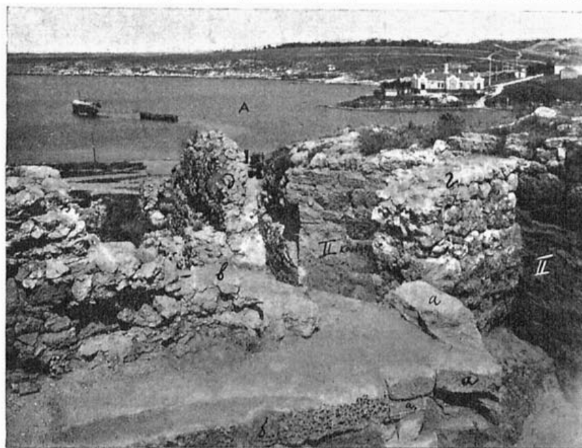
Рис. 52. Верхняя часть ядра башни Зенона с юго-запада: а — ядро; а 1 — замурованный обломок триглифно-метопного фриза; б — вертикальный обрез ядра; в — остаток лестничной клетки византийской эпохи; г — позднейшая стена, изображенная на рис. 49, а.
