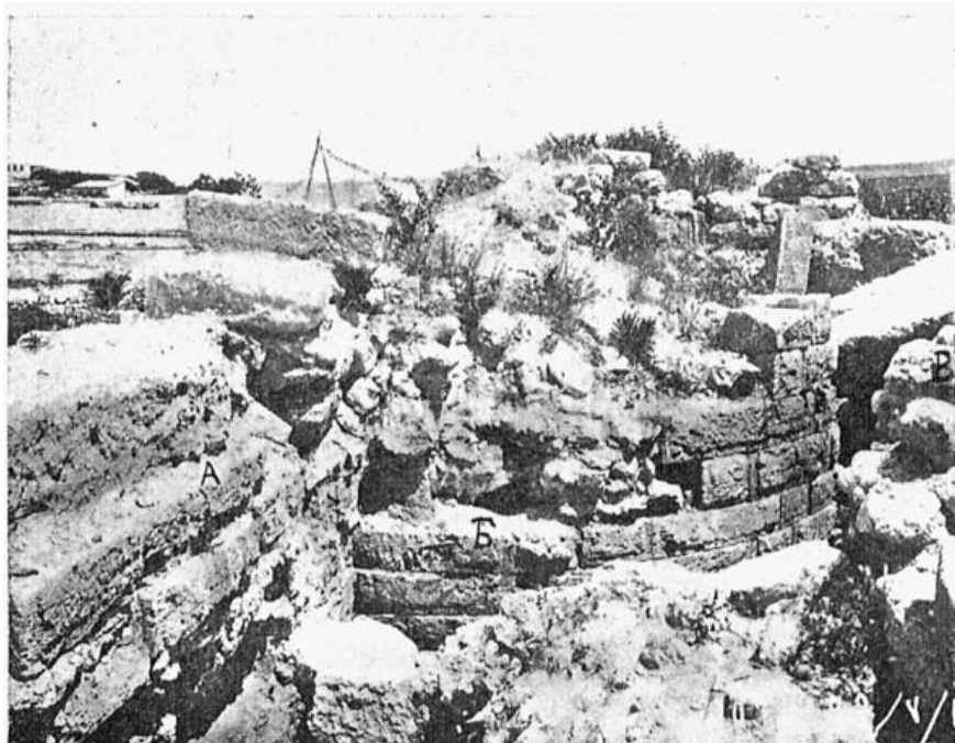
Рис. 74. Полукруглая боковая башня на 20 куртине. А—линия оборонительной стены 20 куртины; Б—полукруглая боковая башня № XVII 1 , одновременная I и II стенам и ядру башни Зенона; В—четыреугольный футляр, одновременный III стене (ср. рис. 73).
