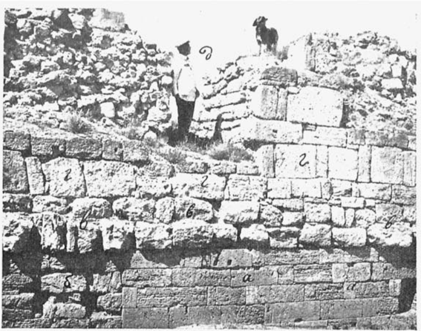
Рис. 88. Деталь кладки 19 куртины (снято с внутренней стороны): а—брусковая кладка 1-го яруса; б—следы какого-то древнего ремонта стены 1-го яруса; в—фундамент 2-го яруса, предназначенный быть в земле; г—кладка 2-го яруса; д—калитка в стене 2-го яруса возле часовни Леонтия (см. рис. 89, а).
