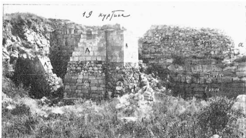
Рис. 90. Современное состояние внутреннего фасада 19 куртины с обрушившейся частью базилики Леонтия (до реставрации).
