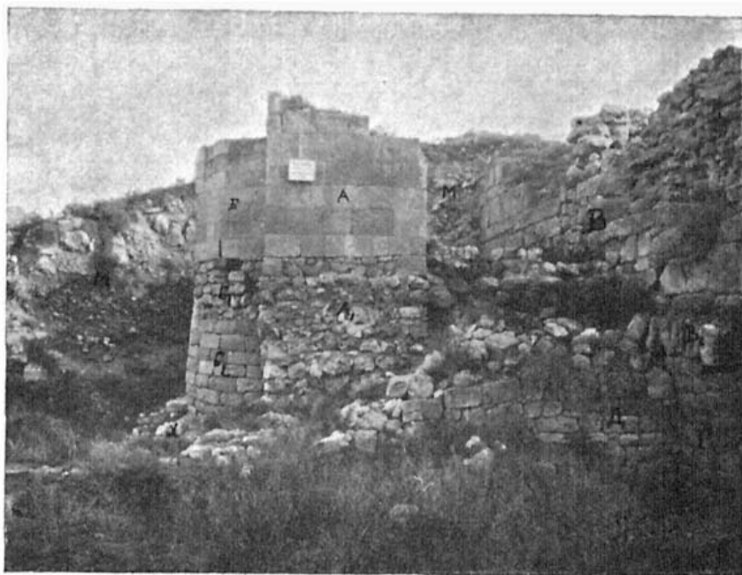
Рис. 11. Базилика „Леонтия, что на забрале“, с севера. А—кладка надземной части нефы; Б—кладка надземной части абсиды; А 1 —подземная бутовая кладка нефы; Б 1 —Б 2 —подземные части абсиды; х—плита, на которой поконтя кладка абсиды; В—кладка III яруса 19 куртины; М—участок, раскопанный в 1927 году.
