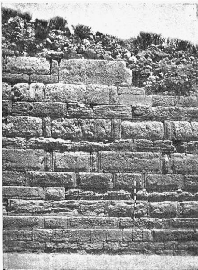
Рис. 13. Образец кладки 16 куртины возле склепа № 1014. Нижние 5 рядов принадлежат древнегреческой эпохе. Следующие 5 рядов—эпохе римского строительства. Еще выше идет средневековая стена.
