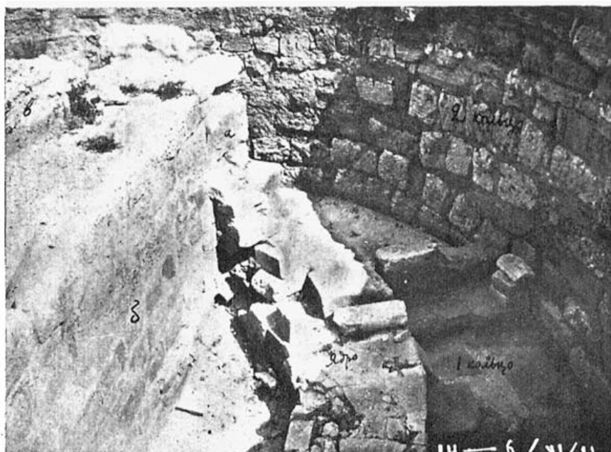
Рис. 64. Вид на внутренность башни Зенона (вид с сев.-запада): а—кладка ядра; а 1 —пироны в форме ласточкина хвоста; б—стена разлома ядра (византийской эпохи).
