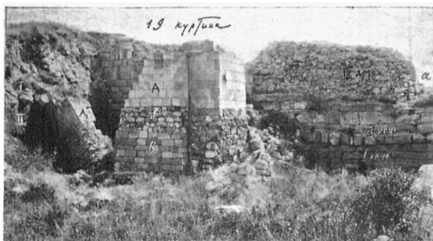
Рис. 10. Общий вид базилики Леонтия в связи с участком раскопок 1927 года (влево, с показанием слоев I и II) на фоне 19 куртины линии оборонительных стен (показаны три яруса кладки стены); а — калитка в III ярусе 19 куртины на уровне пола базилики и одновременная 3-му утолщению XVI башни. Снимок до реставрации 1 авг. 1927 г.
