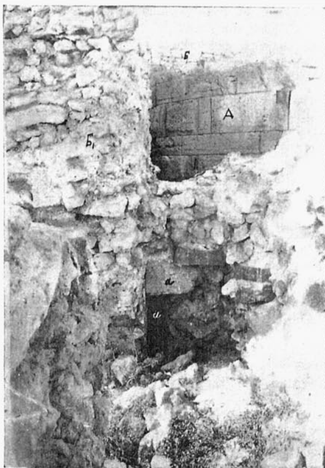
Рис. 72. Место соединения 2-го кольца башни Зенона с 20 куртиной. С сев.-запада: А—ядро башни Зенона древнегреческого времени; Б—Б 1 —2-ое кольцо; а—а—остаток облицовки IV стены, одновременной 2-му кольцу. Впоследствии на этом месте была лестница, ныне бесследно исчезнувшая (ср. рис. 53).
