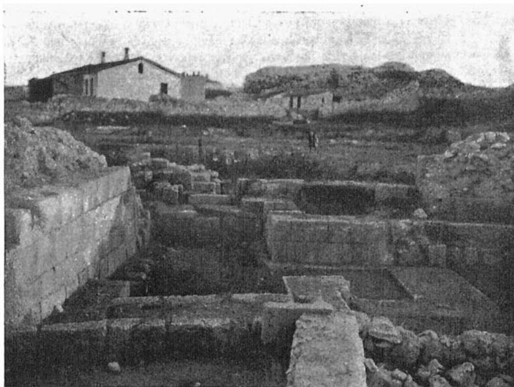
Рис. 38. Общий вид крестообразной башни № XX и восточной стены башни № XXI (слева). На заднем плане—усадьба б. Белозерова. Правее ее—башня Зенона. Снято с севера.
