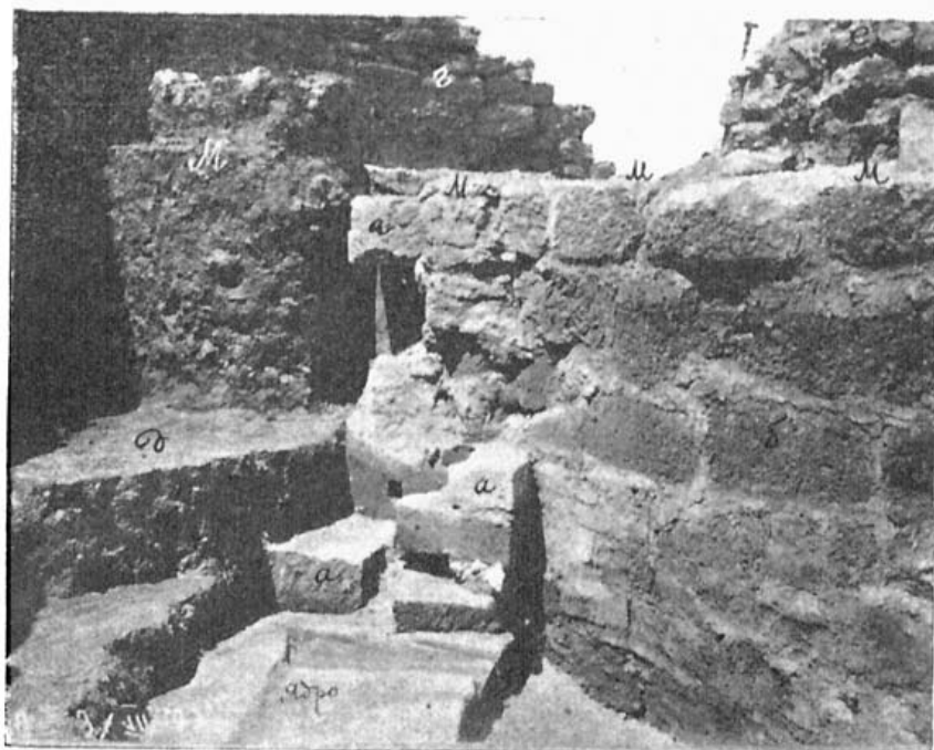
Рис. 51. Раскопка внутренности башни Зенона в 1910 г.: а — ядро; м, д — засыпь над 1-м кольцом; г — 2-е кольцо.
