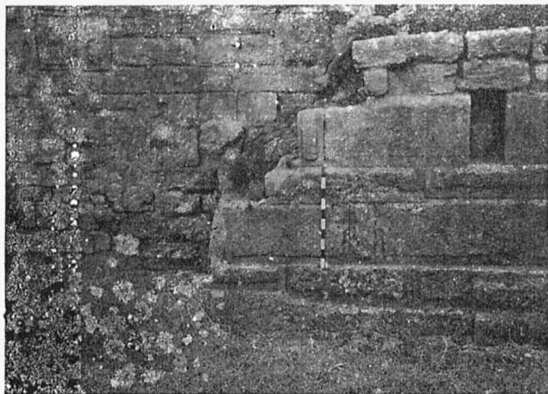
Рис. 29. Деталь кордонной кладки вблизи „пролома“ на 16—17 куртинах.
