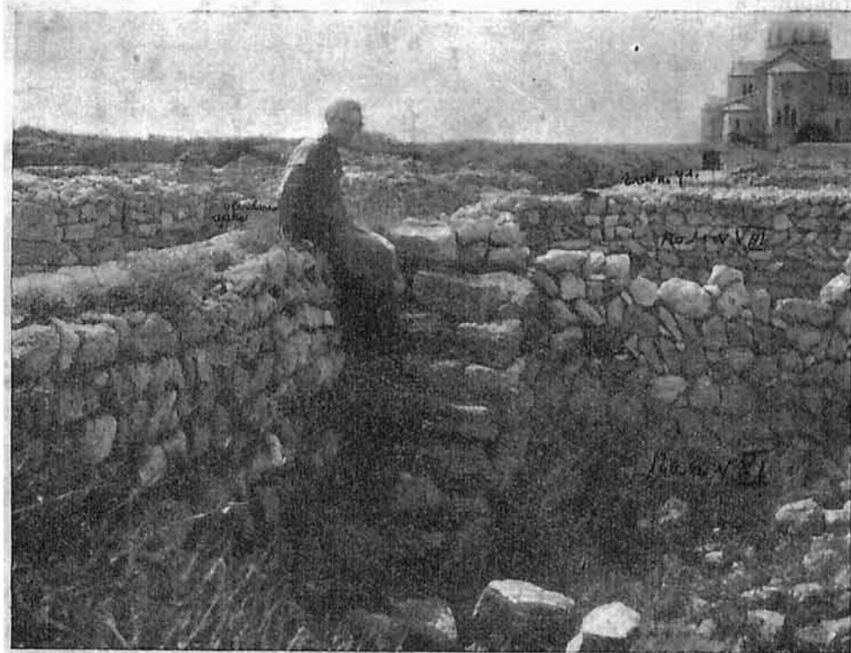
Рис. 10. Вид с севера на помещение № 6 с лестницей (снимок 1929 г.).
