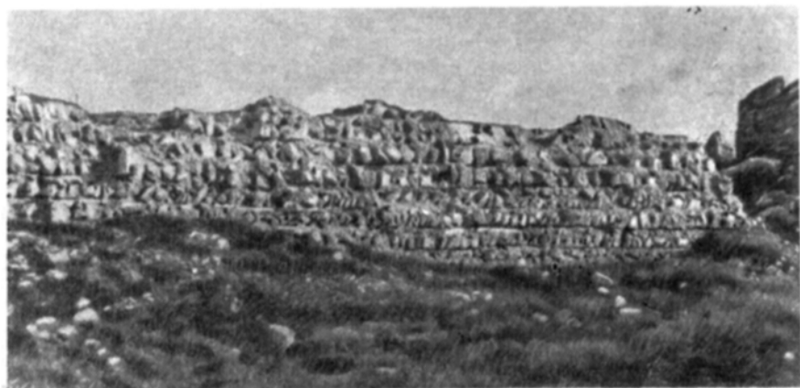
Рис. 23. Внешний вид куртины 3. Забутовка стены со следами рядов облицовочной кладки.
