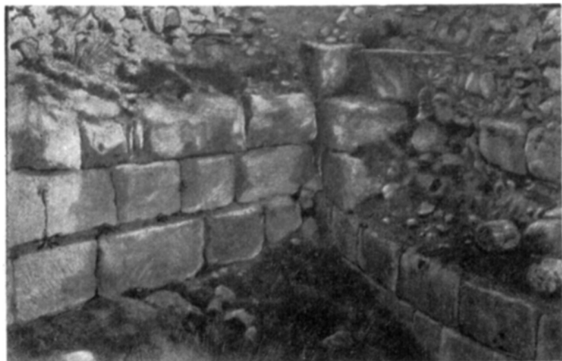
Рис. 22. Место стыка куртины 3 с башней III. Кладка ранневизантийского времени.
