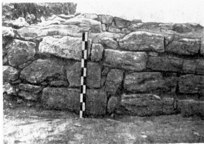
Рис. 64. Стык кладок стен двух строительных периодов на усадьбе клера № 25.
