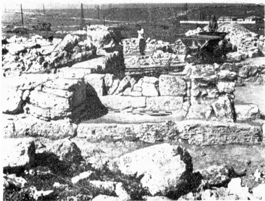
Рис. 104. Наружная дверь усадьбы 2-го строительного периода на клере № 26. Дверь заложена. Вид снаружи.
