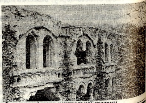
Фрагмент фасаду центральної казарми.
