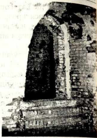
Фрагмент входу до казематів.
