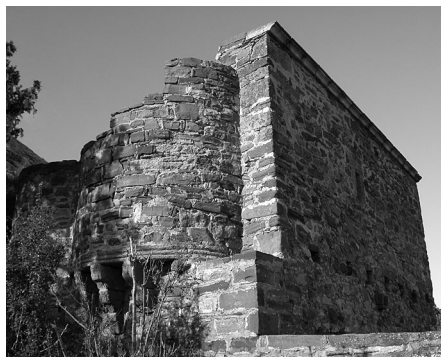
Храм "на консолях". Вид с северо-востока.
