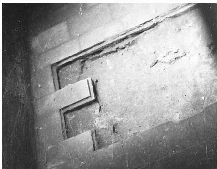
Вымостка пола цистерны донжона Консульского замка.
