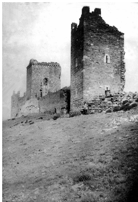
"Георгиевская" башня и комплекс Консульского замка. Вид с северо-запада.
