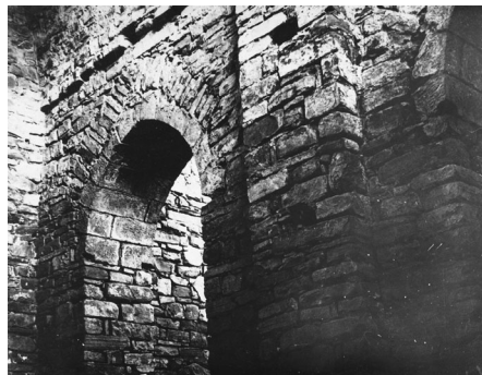
Подпружные арки свода большой цистерны Судакской крепости.
