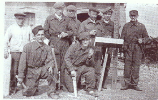
Przy robotach na Odrze, Chobienia 1948-1950 r.
