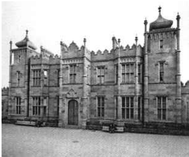
Алупинский дворец. Северный фасад центрального корпуса
