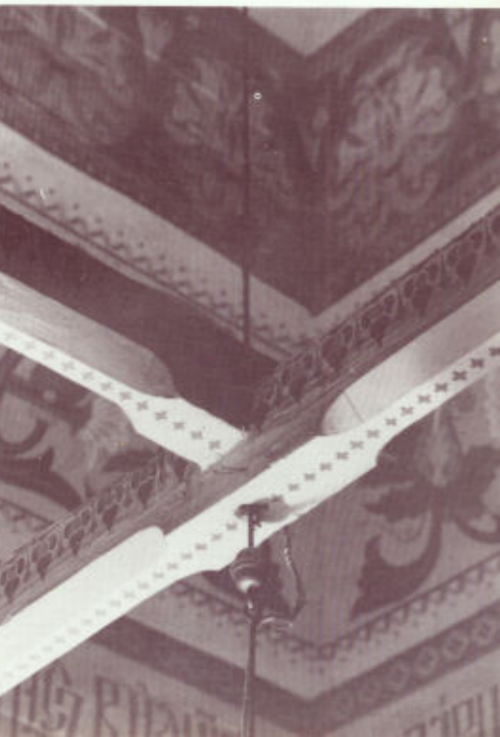
129. Uście Gorlickie, Polska. Cerkiew par. gr.-kat., połączenie ściągów kopuły nawy; 1786
