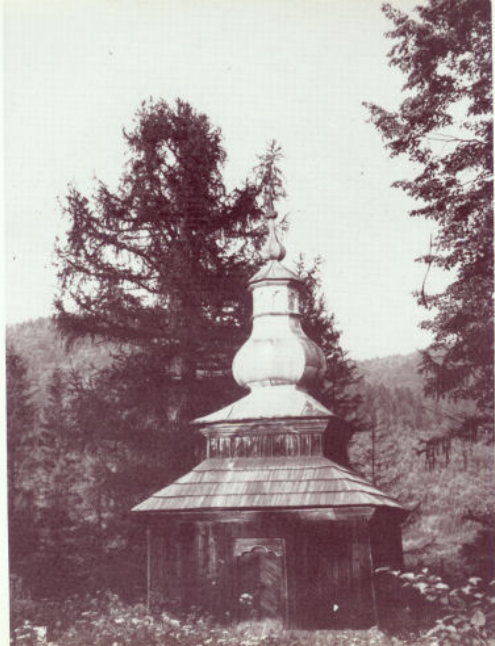
12. Klimkówka, Polska. Dawne prezbiterium cerkwi gr.-kat.: 1754 przenoszona przed 1914. Widok od dawnej strony zach.
