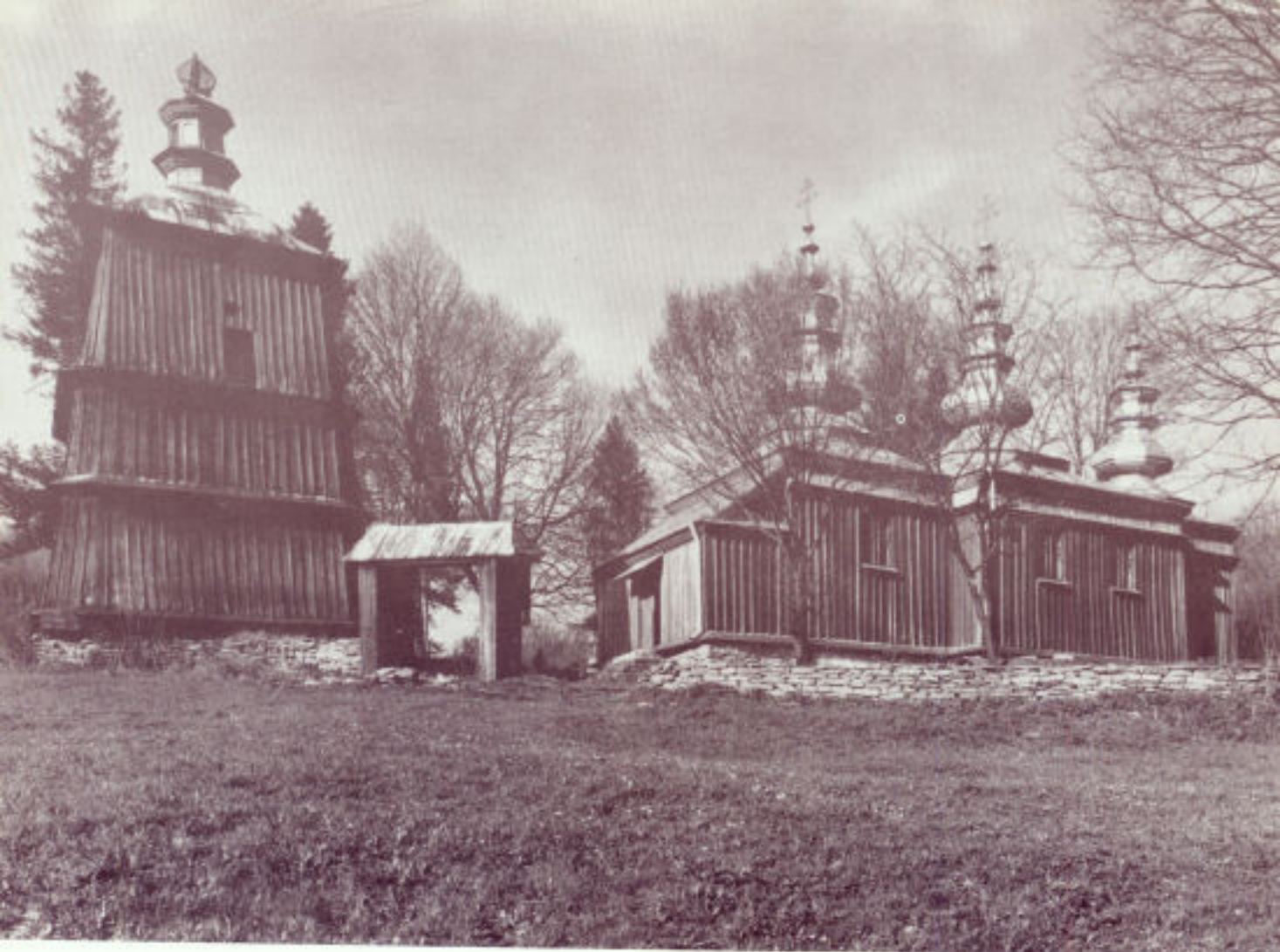
87. Rzepedź, Polska, Cerkiew gr.-kat.; 1824. Widok ogólny od pd.
