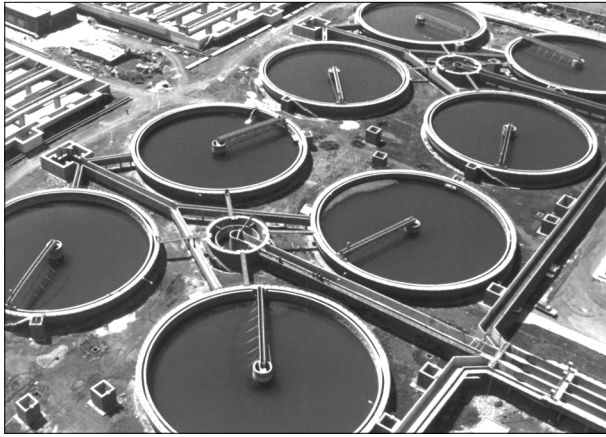
Система очистки промышленных стоков.
