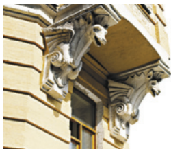
Фрагмент фасада здания по ул. Рейтарской, 31/16
