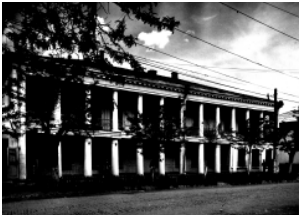
Дом купца Гладиллина, 1831 г. (архитектор О.И. Гаскет) по ул. Харлампиевской (ныне Александру чел Бун). Фото начала 1950-х г. (дом не сохранился)
