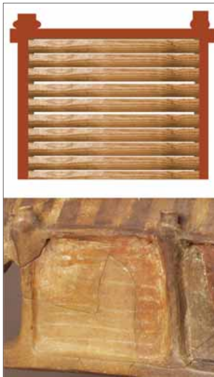
Стіна з горизонтально розташованого колотого дерева: фрагмент стіни моделі із зображенням та схематична реконструкція.
